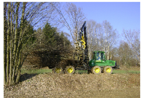
Räumung einer Böschung: WWG Langschlag
